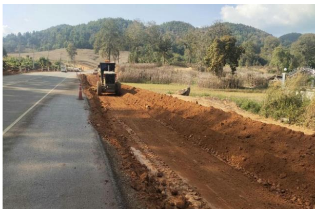
งานกรุยทาง งานดินตัด งานดินถม รูปที่ 1.3-3 กิจกรรมการก่อสร้าง
