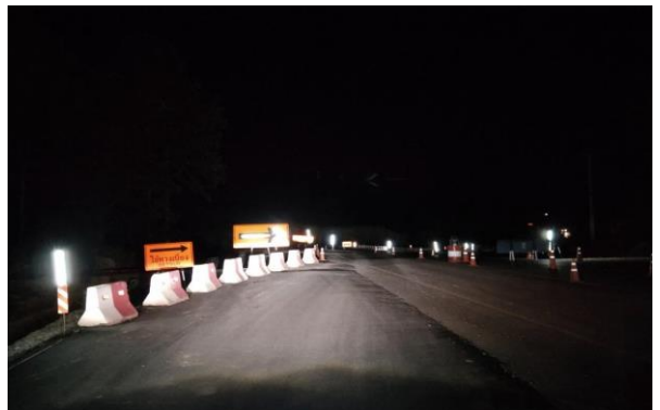
การติดตั้งป้ายโครงการ ป้ายเบี่ยงจราจร และไฟฟาส่งสว่างในพื้นที่ก่อสร้าง รูปที่ 1.3-3 (ต่อ)กิจกรรมการก่อสร้าง
