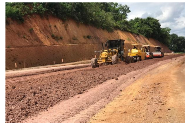
งานกรุยทาง งานดินตัด งานดินถม รูปที่ 1.3-3 กิจกรรมการก่อสร้าง
