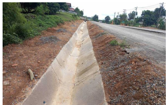
งานป้องกันดินพัง งานระบายน้ำ รูปที่ 1.3-3 (ต่อ)กิจกรรมการก่อสร้าง
